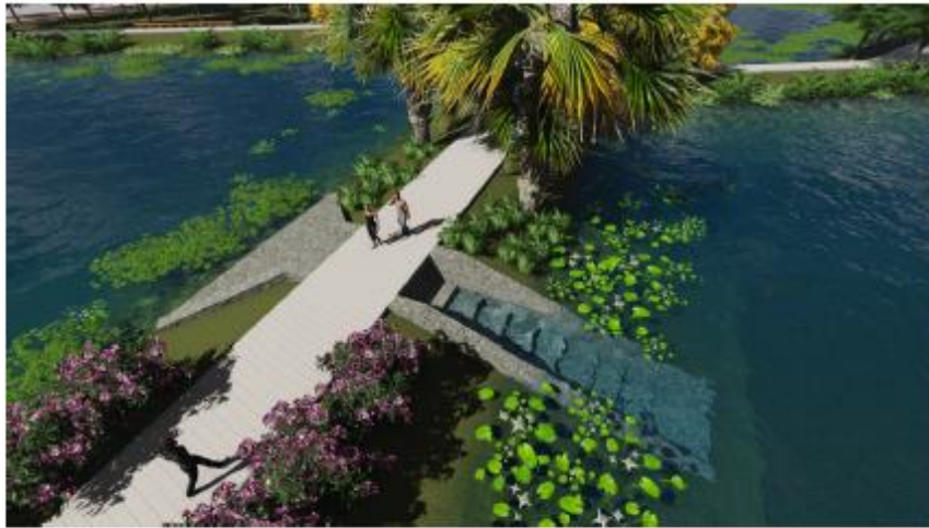
Figura 3 – Bacias de fitorremediação - wetlands. Fonte: Elaborado pelos autores 2016.
